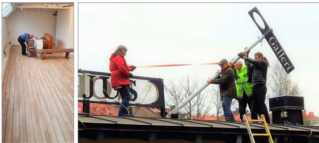
Gallerigolvet slipas och takskyltar räddas.
